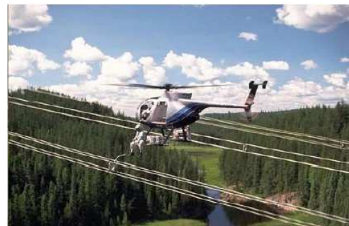
Fig. 1. Inspección de línea de transmisión de energía eléctrica usando un helicóptero con tripulación.
